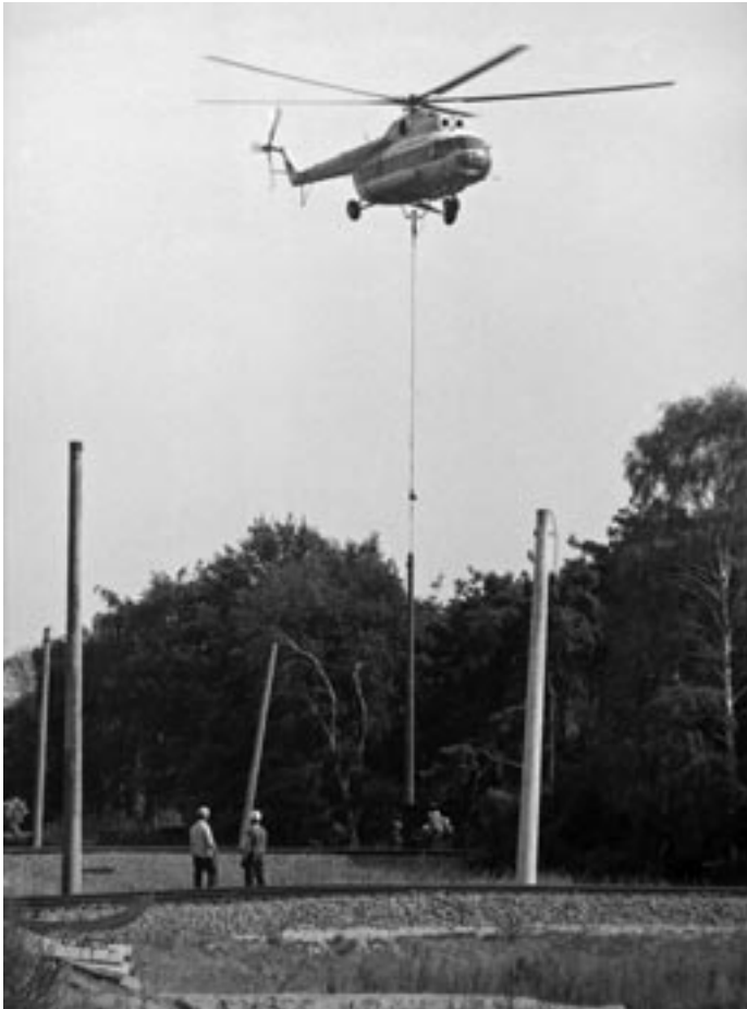
Hubschrauber der Interflug beim Setzen eines Fahrleitungsmast im Bereich Bisamkiez
