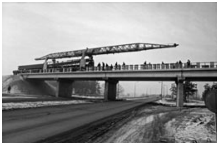
Gleisverlegekran der Reichsbahn „Platow“ im Einsatz
