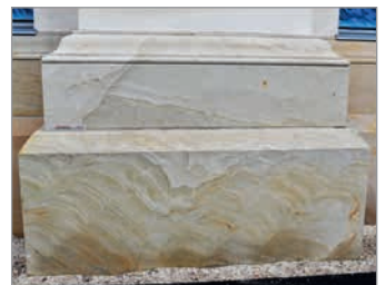
Pilasterbasis aus gebändertem Kreidesandstein mit postsedimentären Störungen
